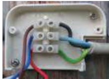
شکل (۲-۱۰) اتصال ترمینالی سیم ها
