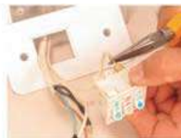
شکل (۲-۱۱) اتصال فیشی سیم
